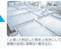
迷宮にキソパッキンロングの「セット位置合わせ部位（セットゲージ）」を合わせてセットする。
